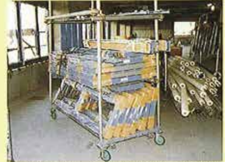
窓枠のストックヤード 足場鉛管を利用した2段式台車
