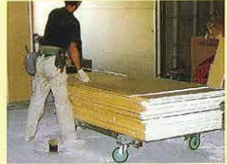
PBの移動と加工台としての利用 台車寸法1m×1m
